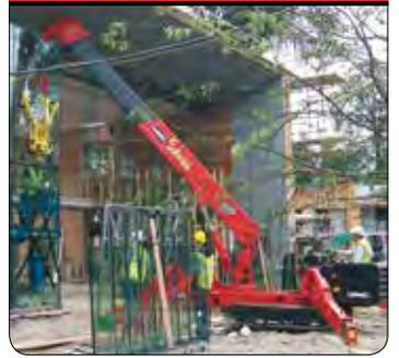
Vakuum-Hebezeug 500 kg
